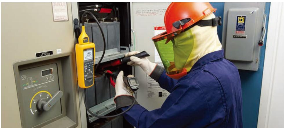
使用 Fluke BT500 測量內阻，每個季度進行每塊電池 / 單元的內阻測試。
