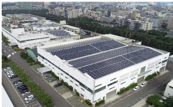
📍 桃園市鋼鐵工廠1.8MW
