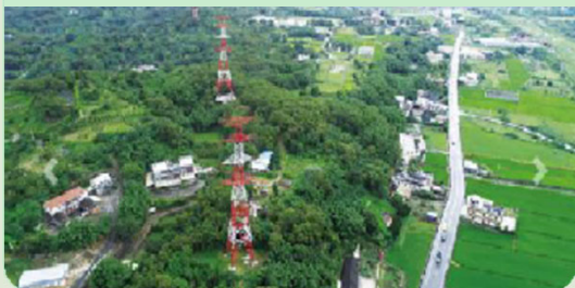
345kV通霄-義和線(第7輸變電計畫)
