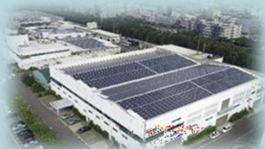
園區廠房 特定工廠
