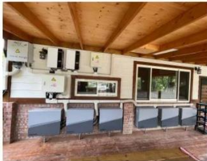
說明: 設備區安裝完成
