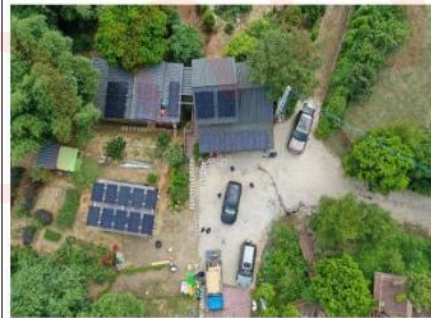
說明: 太陽能板 30PCS 10.05kW 安裝完成
