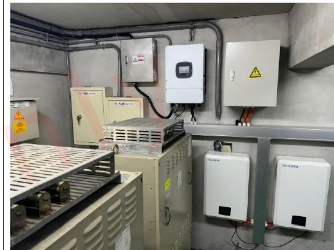
說明: 設備區安裝完成
