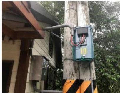
說明: 變壓器及 ATS 箱安裝完成
