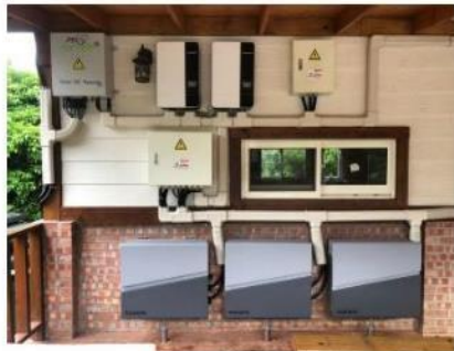
說明: 設備安裝完成
