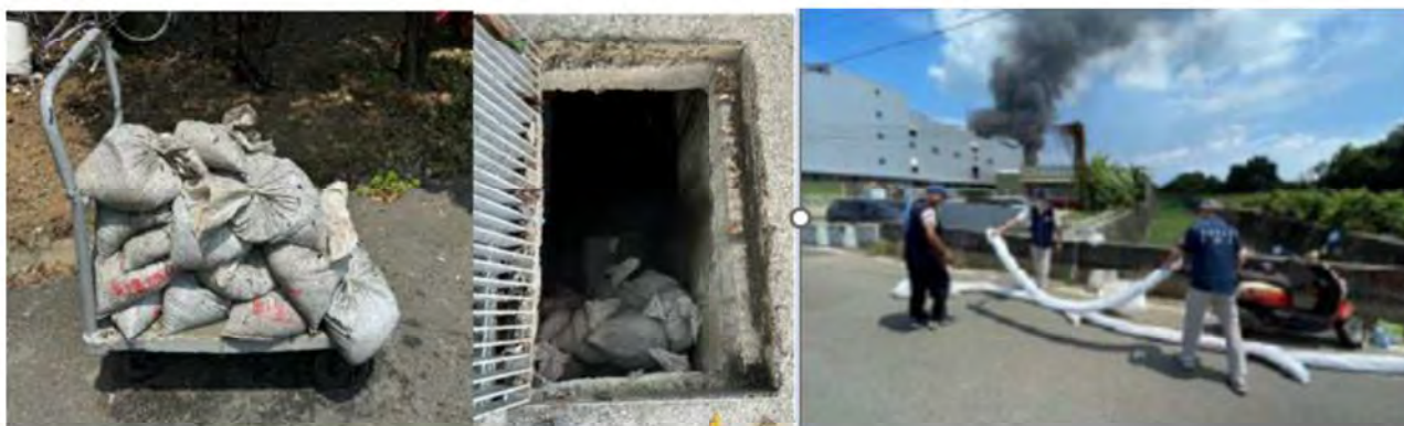
圖五、支援環保局人員進行放置沙包、攔油索阻絕廢水
