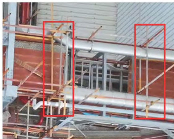
施工架開口處使用欄杆阻斷進行防護確認
