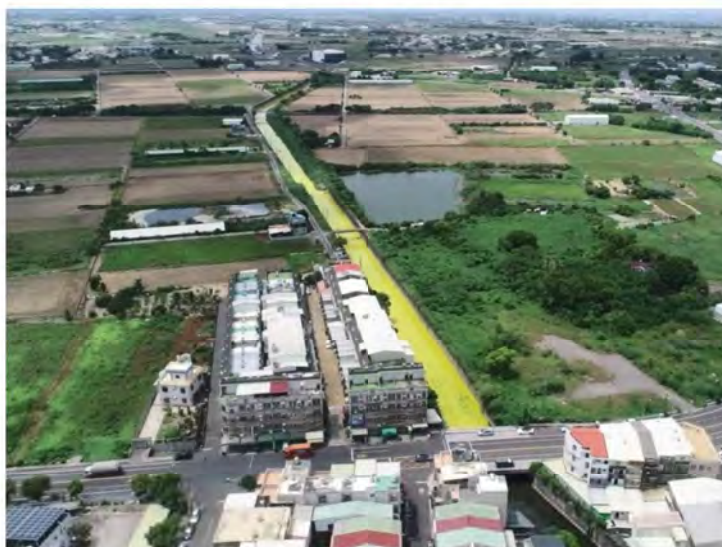
圖四、鹽水大排溢流情形
