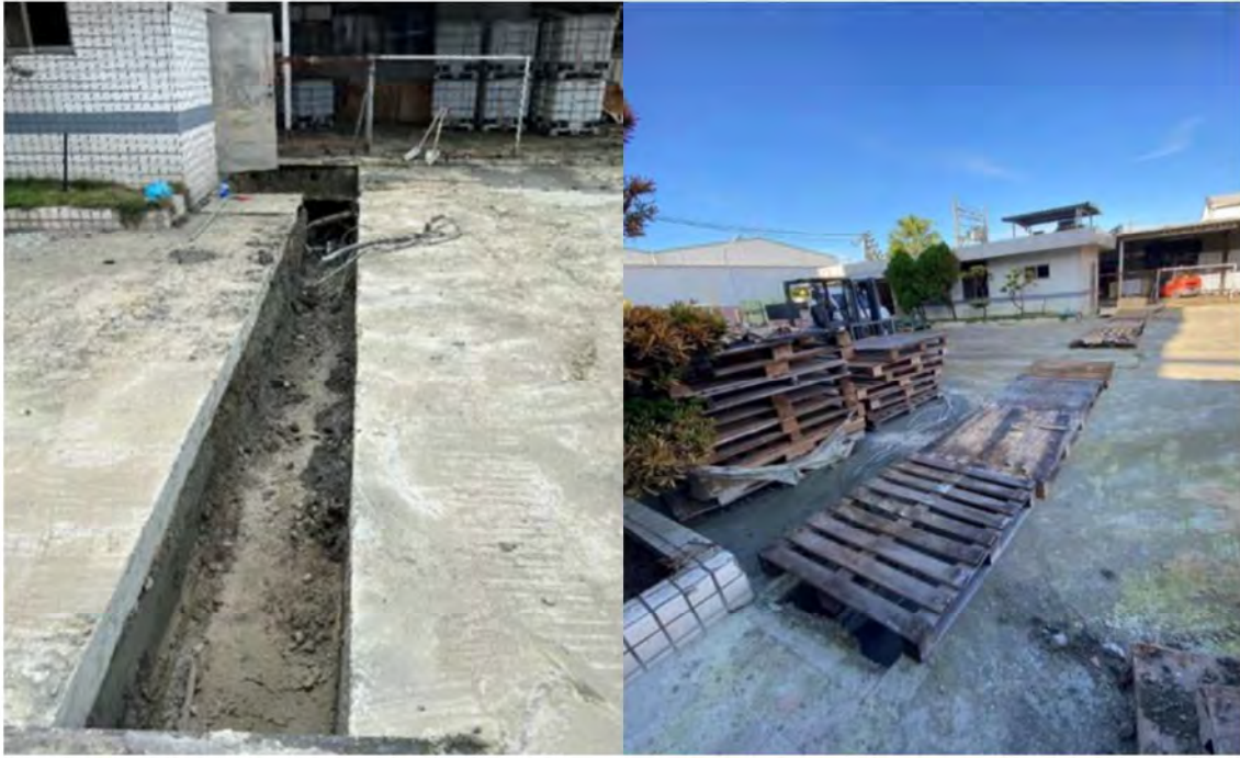
圖九、廠區路面切割設置臨時截流溝
