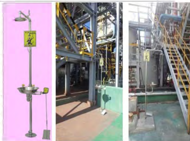
圖八、增設沖淋設備
