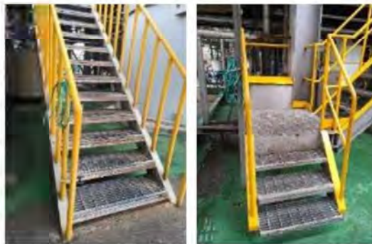
圖七、增設靜電消除設備
