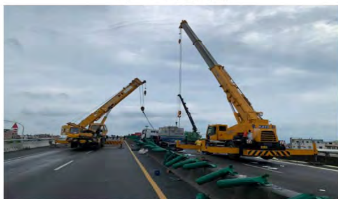
圖五、槽車吊掛扶正
