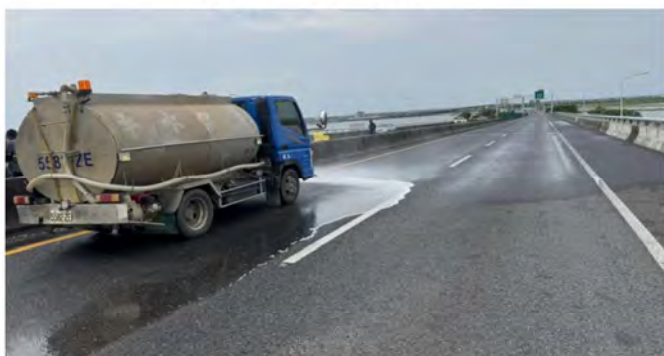
圖七、橋面道路清洗
