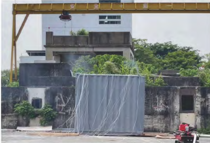
金屬櫃50秒後鋼樑撈彎，門板釋壓開啟
